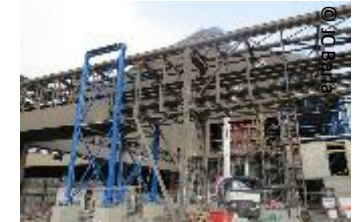
Construction du four-poche ArcelorMittal Méditerranée
