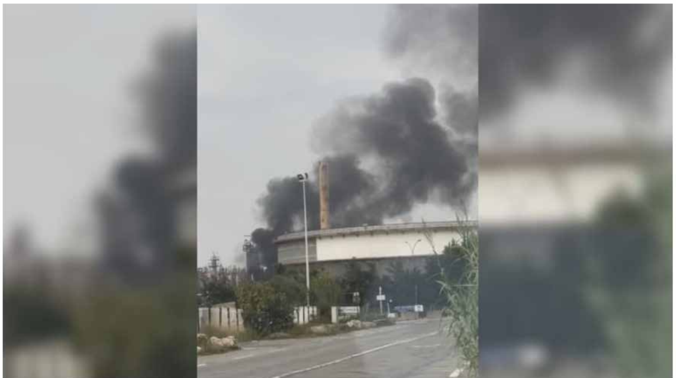
Une fuite sur une canalisation a eu lieu ce samedi sur le site ESSO à Fos-sur-Mer - BFM Marseille Provence
