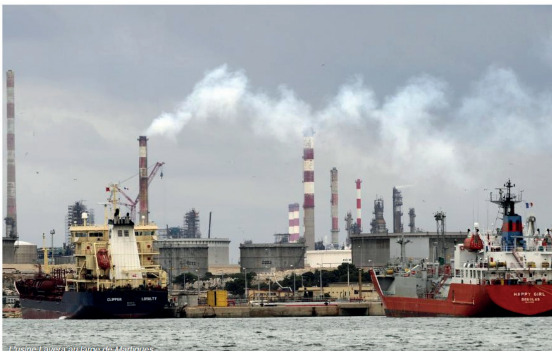
L'usine Lavéra au large de Martigues.
