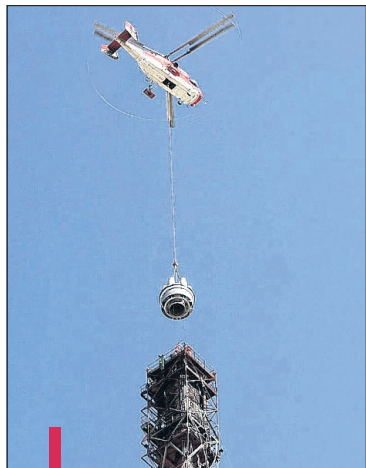
En octobre 2018, un chantier spectaculaire pour changer le nez d'une torche de Naphtachimie.
