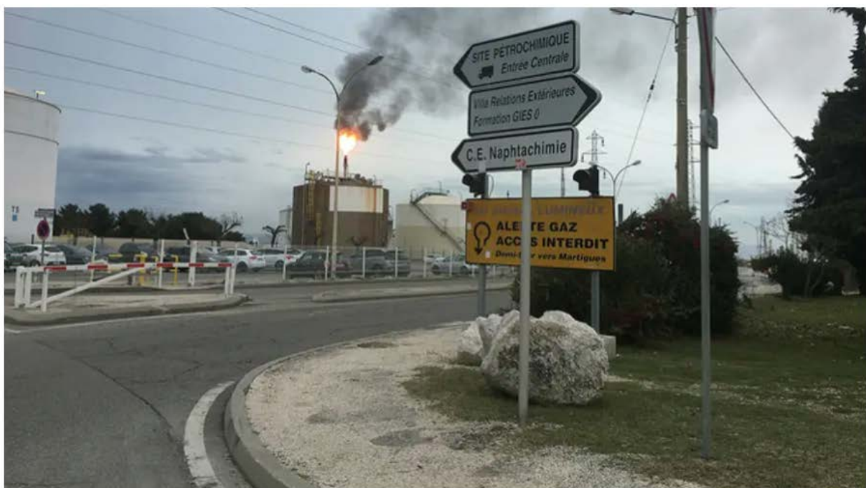
Avant-hier, à la suite d'une coupure électrique, Naphtachimie a déclenché sa torche, le temps de redémarrer son vapocraqueur. PHOTO E.G.
