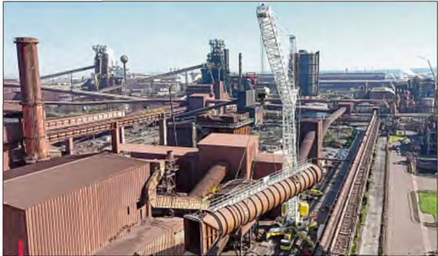
Le système de filtration, baptisé Odas (O Dust at Sinter Plant), est en cours d'installation.
